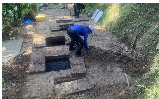
Inspección de infraestructura de tratamiento de aguas.
