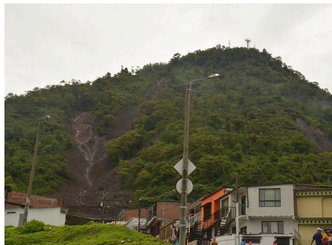
Obras de mitigación de riesgos – Morro de Sancancio
