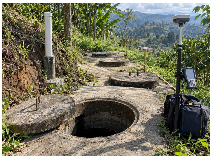
Mejoramiento integral del alcantarillado rural
