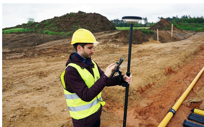
Georreferenciación y levantamiento del terreno.
